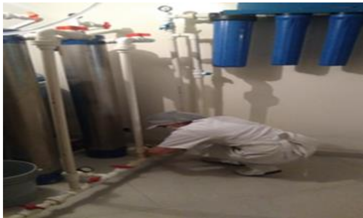
Imagen 02 Cierre de filtro para limpieza
