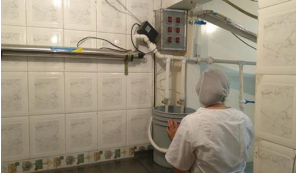
Imagen 08. Limpieza Filtro ultravioleta
