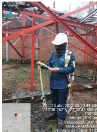
Ilustración 6. Inspección de Eslingas: El personal nos muestra la inspección de la eslinga de posicionamiento y en Y
